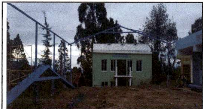
Foto 3: Se sustituye estructura de madera por estructura de metal.
