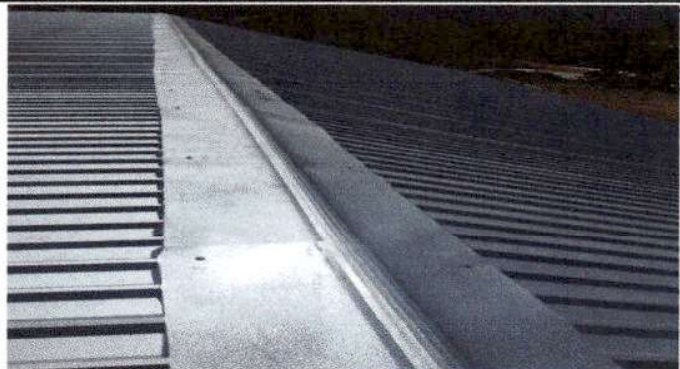
Foto 2: Se sustituye capote de lámina, por capote de lámina troquelada.
