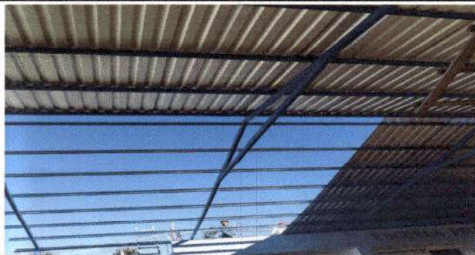
Foto 1: Se sustituye lámina deteriorada, por lámina troquelada aluzink calibre 26, en el area de patio.
